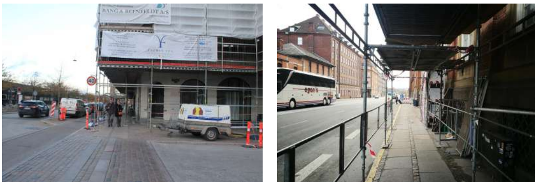
Foto 4.3: Bumbung keselamatan di atas laluan pejalan kaki di tapak pembinaan di Copenhagen, Denmark
