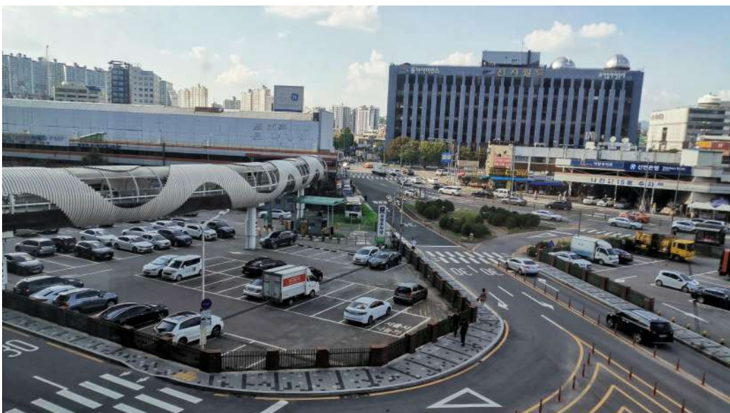
Foto 4.2: Pandangan udara lintasan tanpa isyarat ( unsignalized ), pada-gred ( at-grade ) di Seoul, Korea Selatan
