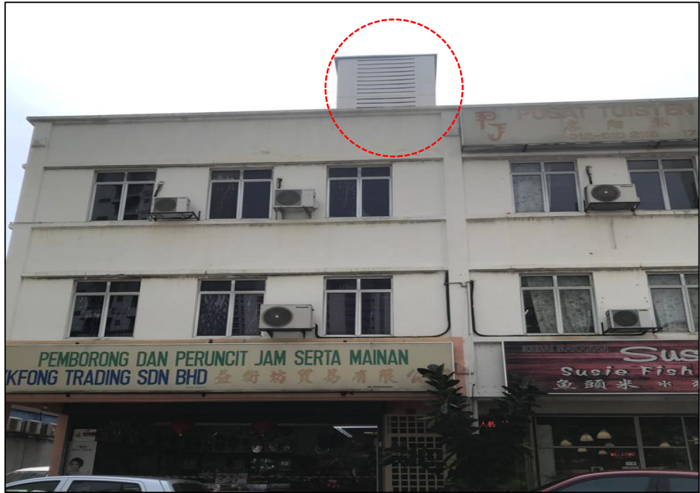
Pandangan Dari Bawah Struktur Telekomunikasi Yang Terlindung / Camouflage
