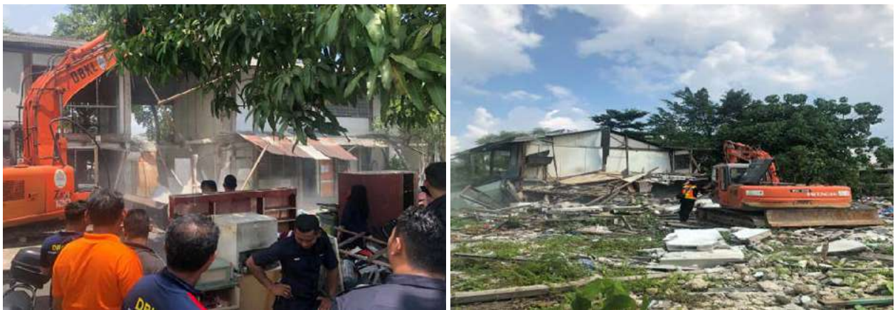
Operasi Meroboh Rumah Panjang Jinjang Utara telah diadakan pada 3 Mei 2019 di Rumah Panjang Jinjang Utara
