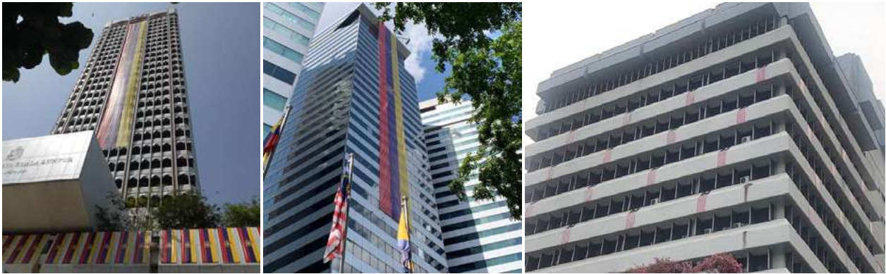
Pemasangan Bendera Wilayah Persekutuan Di Menara DBKL 1, 2 Dan 3 Sempena Sambutan Hari Wilayah Persekutuan Tahun 2019
