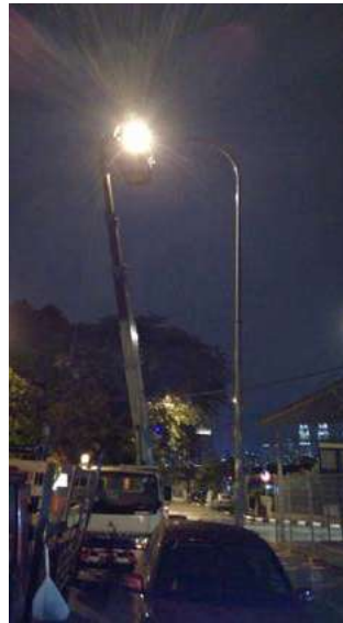
Lampu Jalan HPSV (Retrofit)
