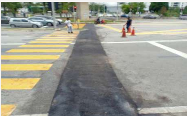
KERJA-KERJA PASANG/GANTI KABEL LAMPU ISYARAT
