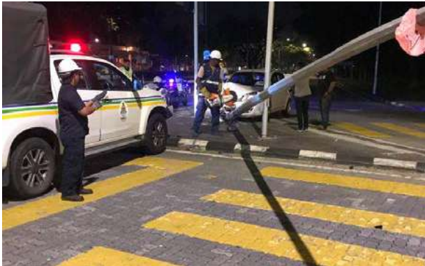
Kerja-kerja kecemasan mengalihkan tiang elektrik yang menyebabkan kesesakan lalu lintas di Jalan Bukit Bintang pada 5 Oktober 2020.
