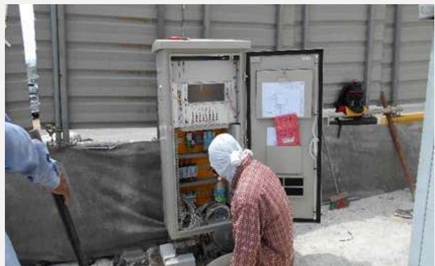
KERJA-KERJA INFRA LINKING SISTEM LAMPU ISYARAT
