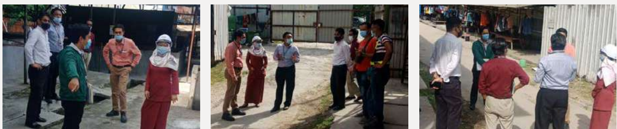
Lawatan tapak bagi pemantauan binaan sementara di dalam kawasan tapak bina
