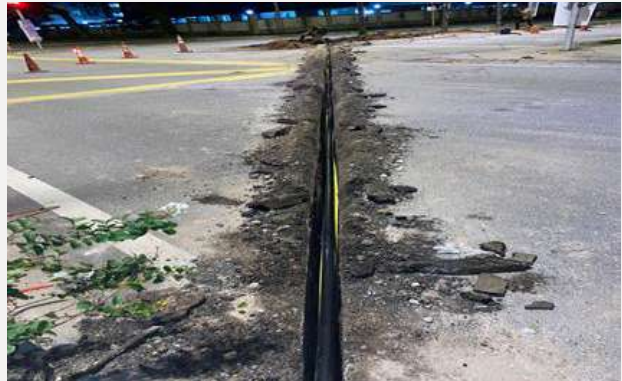
KERJA-KERJA INFRA LINKING SISTEM LAMPU ISYARAT
