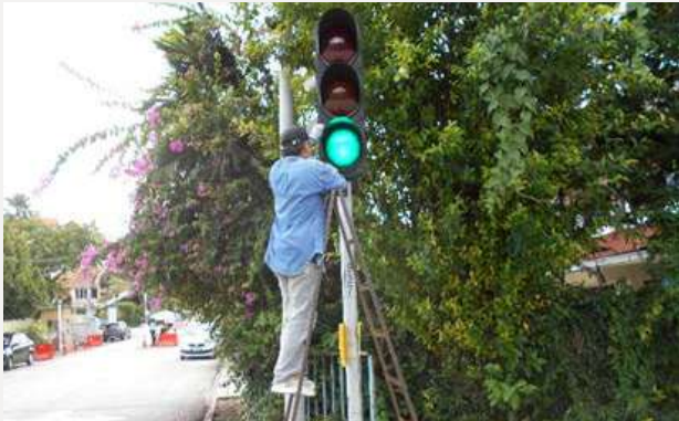
KERJA-KERJA PASANG/GANTI KABEL LAMPU ISYARAT
