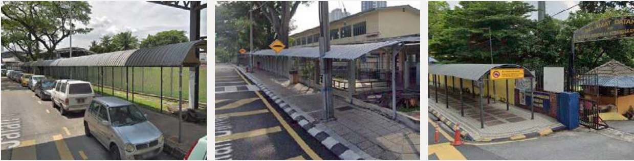
Kerja-kerja penyelenggaraan siarkaki berbumbung di sekitar Wilayah Persekutuan bagi tahun 2020
