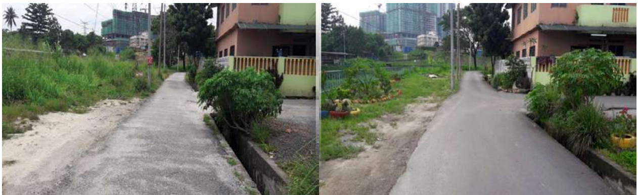
Jalan-jalan yang telah siap di turap
