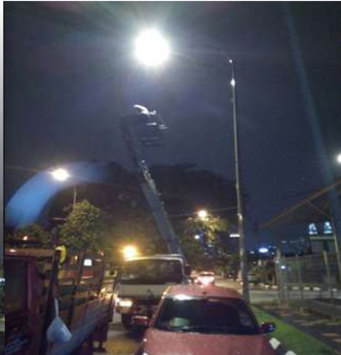
Kerja-kerja Retrofit Lampu Jalan HPSV Kepada Lampu Jalan LED
