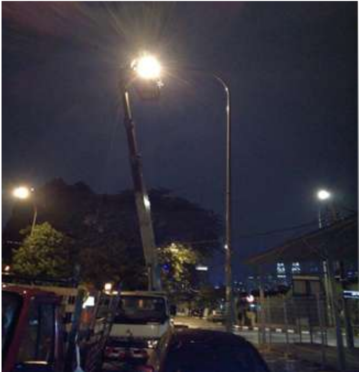
Kerja-kerja Retrofit Lampu Jalan HPSV Kepada Lampu Jalan LED
