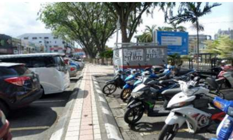
Gambar 13: Pemandangan ke arah kawasan sekitar TNB SubStation (SEBELUM)
