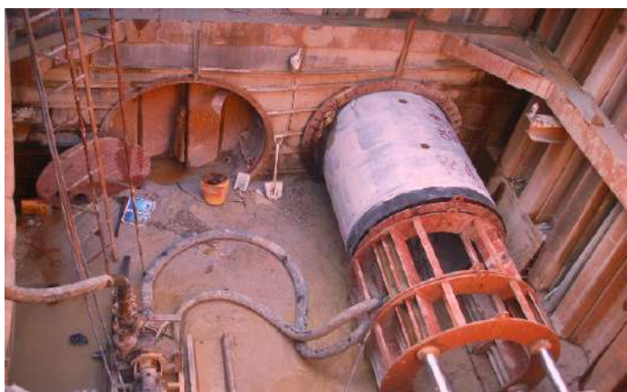
Pembinaan Kalbat Kekotak di Taman Goodwood Jalan Kelang Lama
