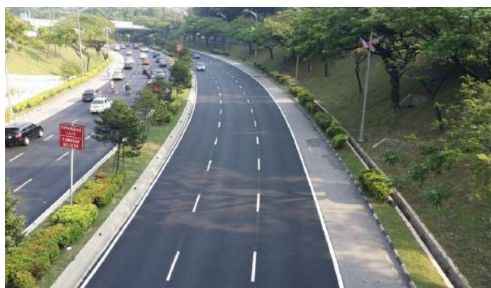
Kerja-kerja Penurapan Jalan Di Jalan Istana
