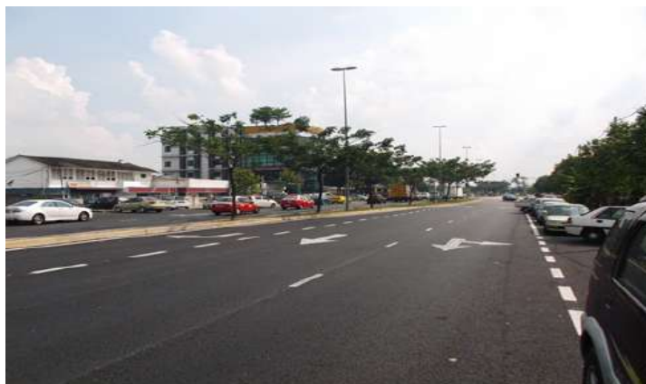
Kerja-kerja Penurapan Jalan Gombak
