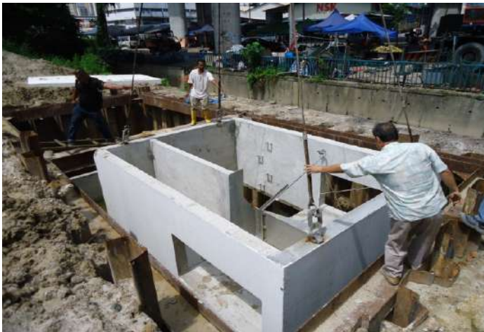
Pembinaan Gross Pollutant Trap
