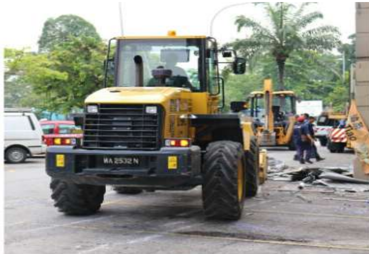
Operasi Meroboh Binaan Tanpa Izin Di Sekitar Kuala Lumpur (Operasi Bersepadu)
