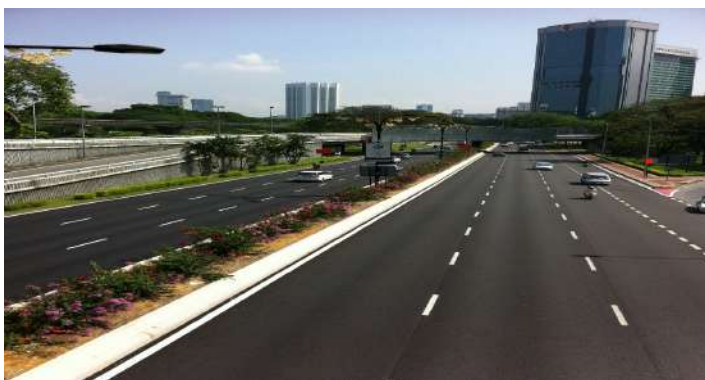
Kerja-kerja Penurapan Jalan Di Jalan Syed Putra
