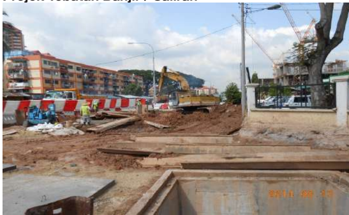
Pembinaan Struktur Kalbat di Jalan Madrasah Gombak
