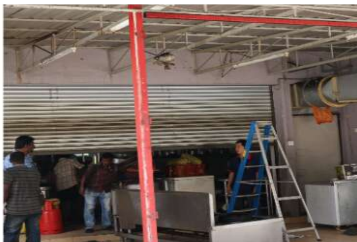
Operasi Meroboh Binaan Tanpa Izin Di Sekitar Kuala Lumpur (Operasi Bersepadu)
