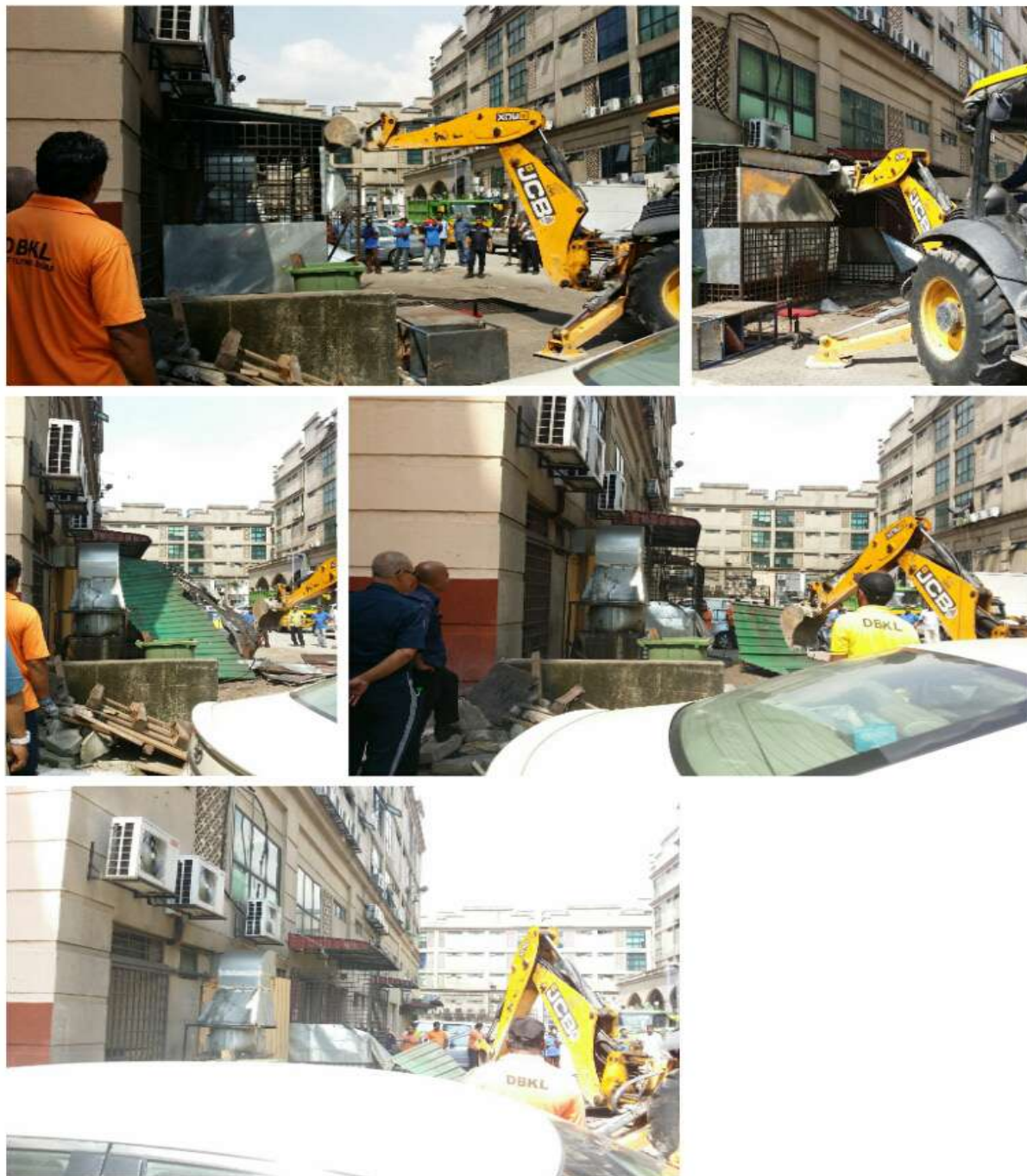
Operasi Meroboh Binaan Tanpa Izin Di Sekitar Kuala Lumpur (Operasi Bersepadu)
