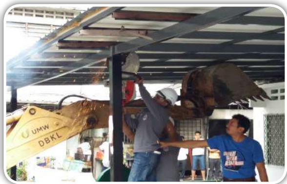
Operasi Roboh Sedang Dijalankan
