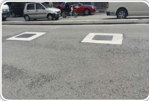
JALAN PUDU - TELEKOM MALAYSIA
