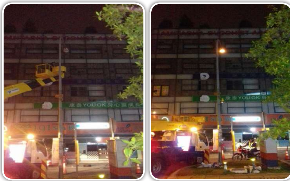
Penyelenggaraan untuk kerosakan kecil Lampu Jalan
