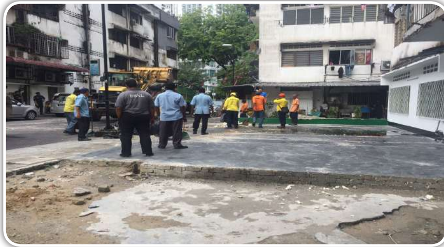
Operasi Meroboh Telah Selesai Dijalankan
