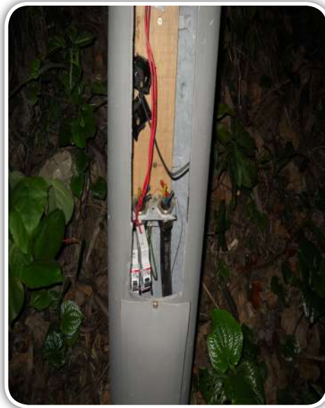
Feeder pillar dipecah dan kabel dipotong
