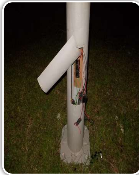
Feeder pillar dipecah dan kabel dipotong
