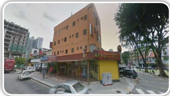
Operasi Meroboh Sedang Dijalankan
