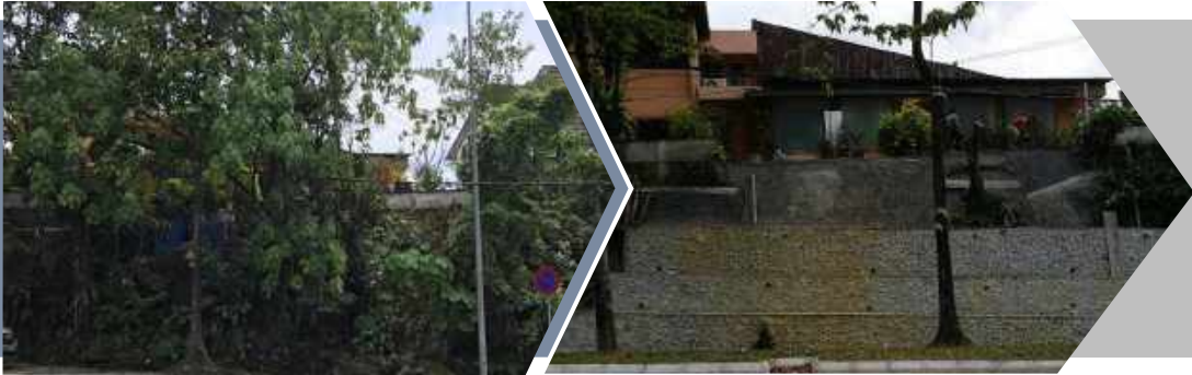
Kerja-kerja pembaikan cerun dan kerja-kerja berkaitan di Lorong Bukit Pantai, Taman Bukit Pantai, Kuala Lumpur
