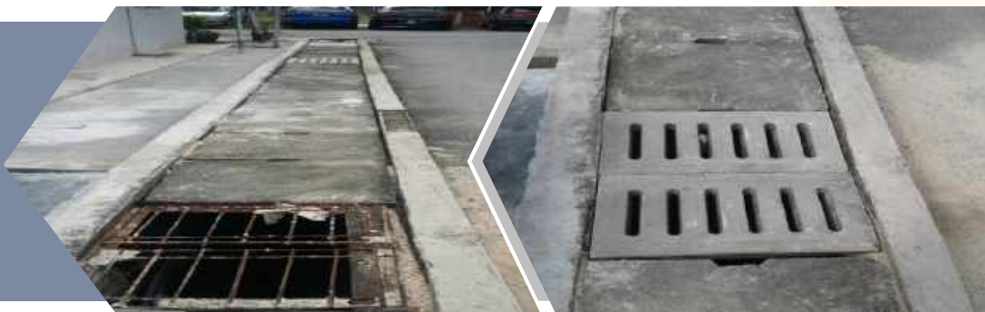
Kerja-kerja penyelenggaraan lurang/manhole
