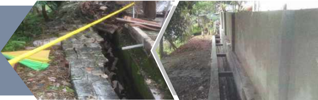
Kerja-kerja pembaikan cerun dan kerja-kerja berkaitan di Lorong Badang 5, Bandar Baru Sri Petaling, Kuala Lumpur
