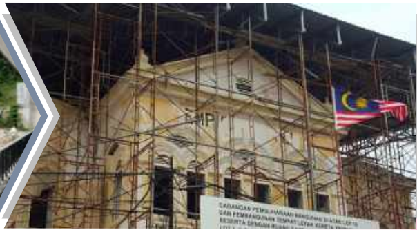
Gambar 12 : Penyediaan lapisan bumbung sementara di atas bangunan asal bagi mematuhi keperluan dan syarat-syarat konservasi bangunan warisan semasa peringkat pembinaan
