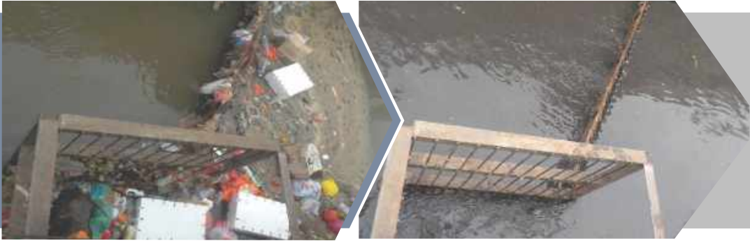
Pembersihan di statik skrin berhampiran Jalan Jinjang Aman 4, Kepong
