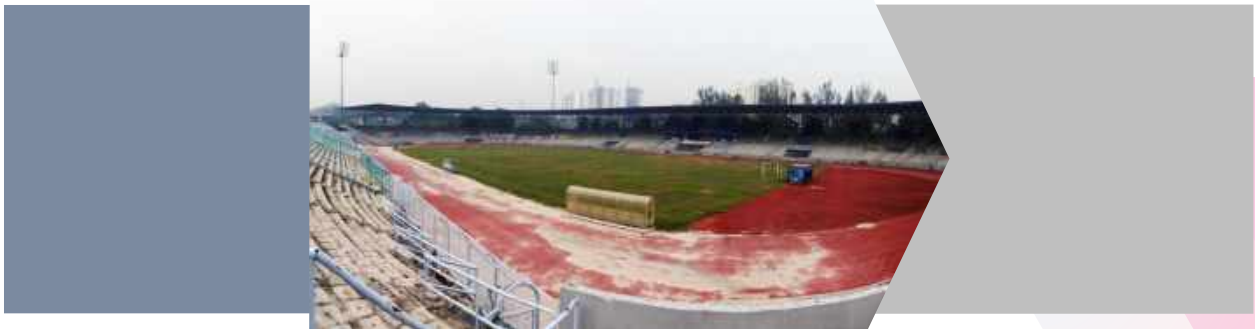
Gambar 1: Keadaan padang dan trek balapan sebelum kerja-kerja naiktaraf
