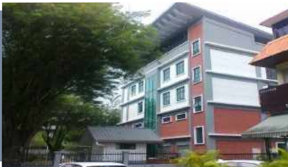
Gambar 18 : Pandangan hadapan bangunan yang telah siap
