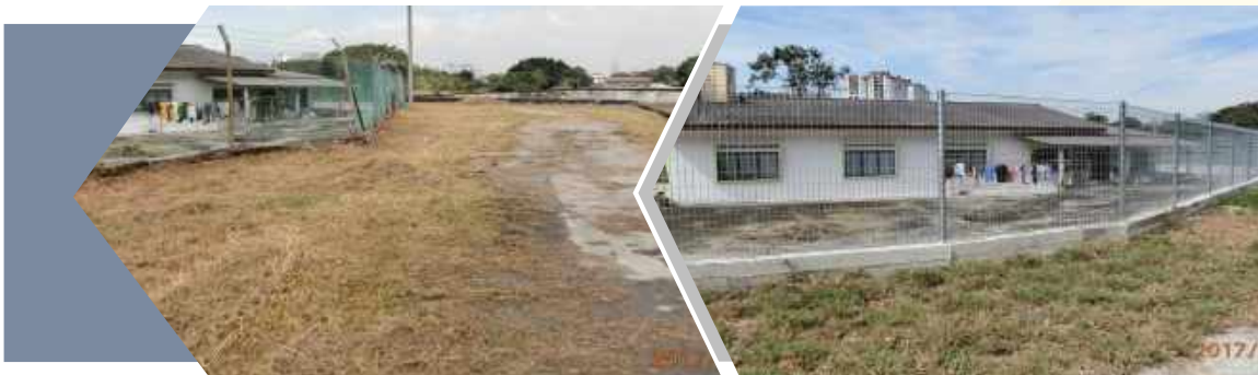
Kerja-kerja memasang pagar keselamatan Anti Climb di KTB Kg. Cheras Baru
