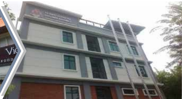
Gambar 19 : Pandangan hadapan bangunan yang telah siap
