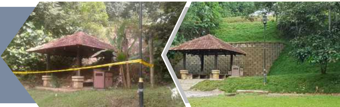
Kerja-Kerja Pembaikan Cerun Dan Kerja-Kerja Berkaitan Di Taman Rimba Bukit Kerinchi, Lembah Pantai, Kuala Lumpur
