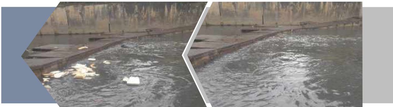
Pembersihan di Floating Boom berhampiran Jalan Beremban, Kepong
