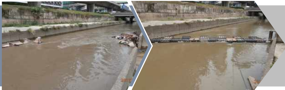
Kerja-kerja memasang baru perangkap sampah terapung ( Floating Boom ) di Sungai Klang
