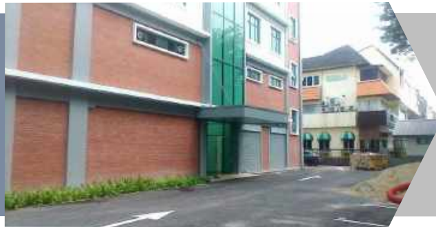
Gambar 20 : Pandangan >>> hadapan bangunan yang telah siap
