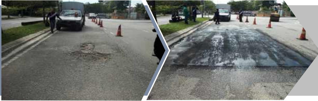
Jalan-jalan yang telah siap di turap
