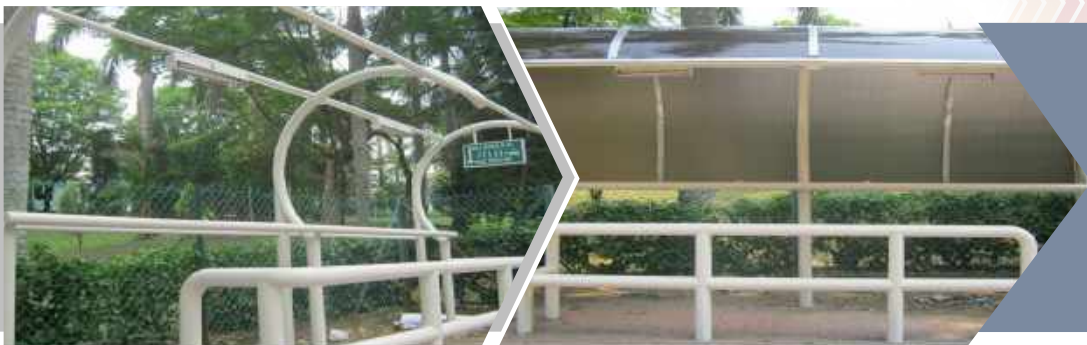
Kerja-kerja menukar bumbung dan mengecat hentian bas
