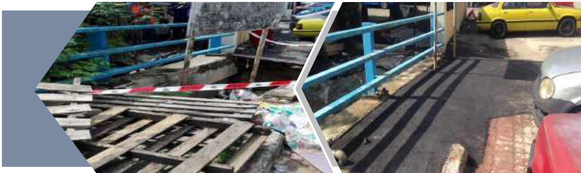
Kerja-Kerja penyelenggaraan di Desa Tun Razak
