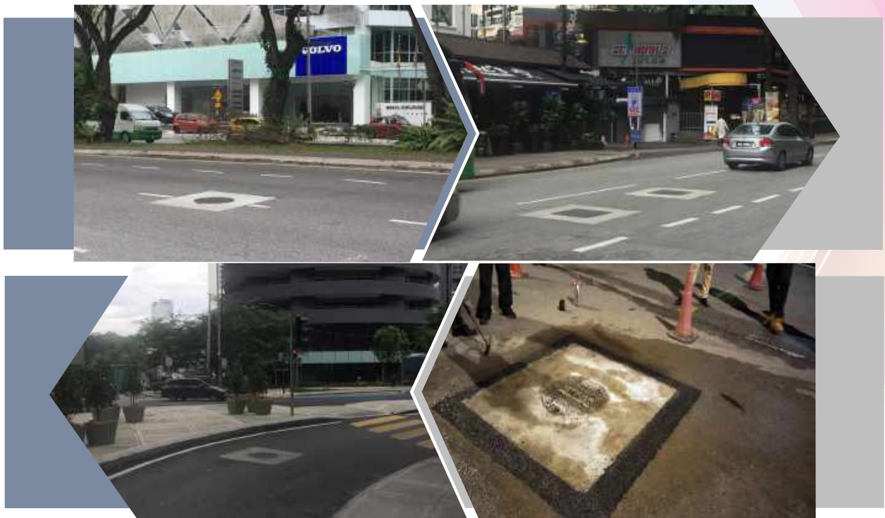
Kerja-Kerja Menaiktaraf 'Man-Hole Cover Pre-Cast Slab' Di Jalan-Jalan Sekitar Wilayah Persekutuan Kuala Lumpur
