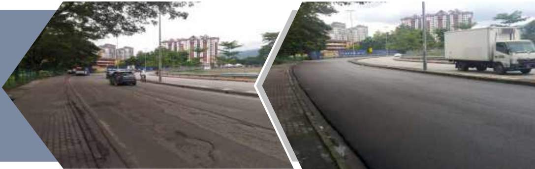
Kerja-kerja penyelenggaraan jalan oleh tenaga kerja jabatan
