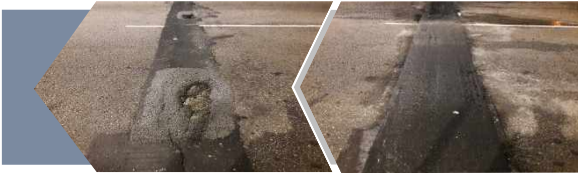
Penyelenggaraan jambatan merentasi Jalan Damansara
