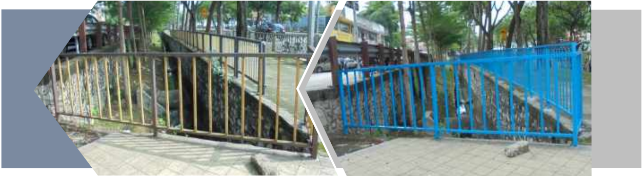
Kerja-kerja mengecat pagar keselamatan saluran induk
