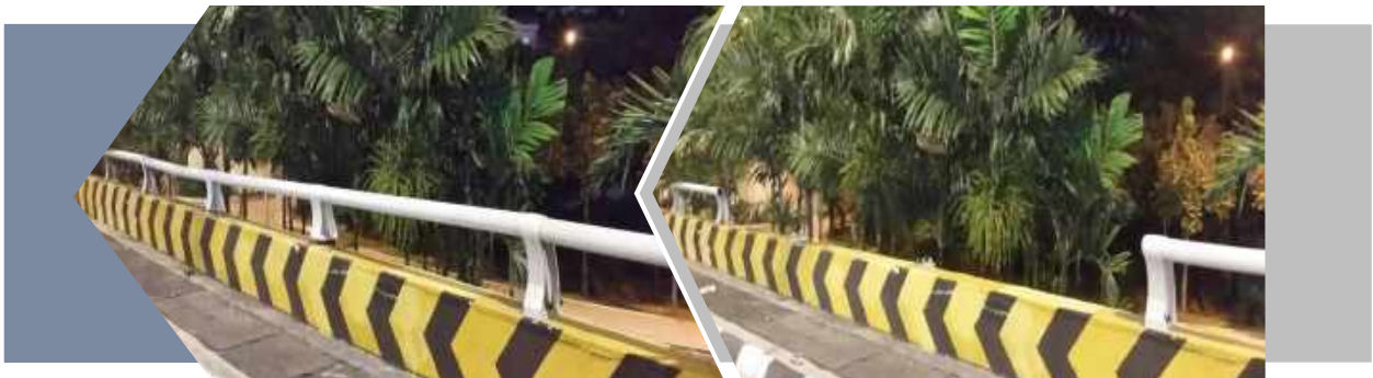
Penyelenggaraan jambatan merentasi Jalan Damansara
