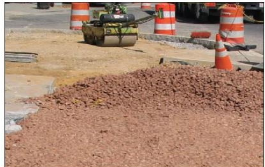
Gambarajah 3.10 Contoh-contoh ruang penanaman tertutup menggunakan 'structural soil'.
