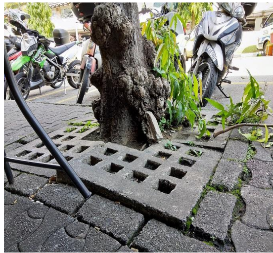
Gambarajah 3.1 Keadaan Siarkaki yang rosak disebabkan akar pokok dan gambar aerial menunjukkan Penanaman pokok di kawasan pusat bandaraya adalah terhad dan berhampiran dengan struktur binaan
