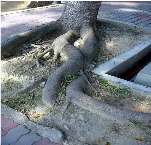
Gambarajah 3.1 Keadaan Siarkaki yang rosak disebabkan akar pokok dan gambar aerial menunjukkan Penanaman pokok di kawasan pusat bandaraya adalah terhad dan berhampiran dengan struktur binaan
