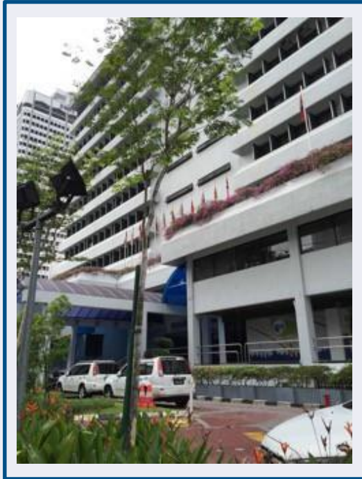
Contoh Pemasangan Tiang Bendera Di Atas Podium (Tidak Melebihi 3 Tingkat Dari Aras Jalan)
